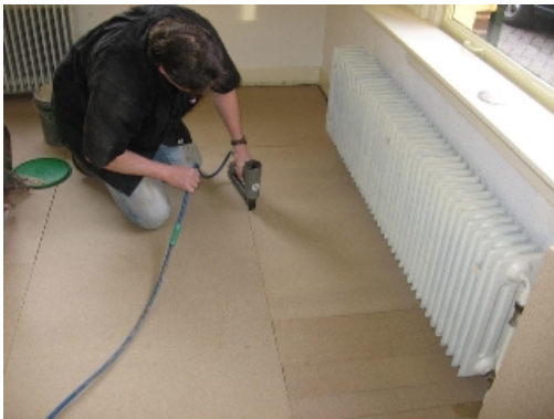
De parketteur legt de ondervloer
